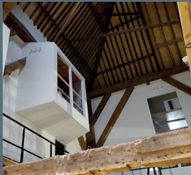
Interieur in aanbouw
