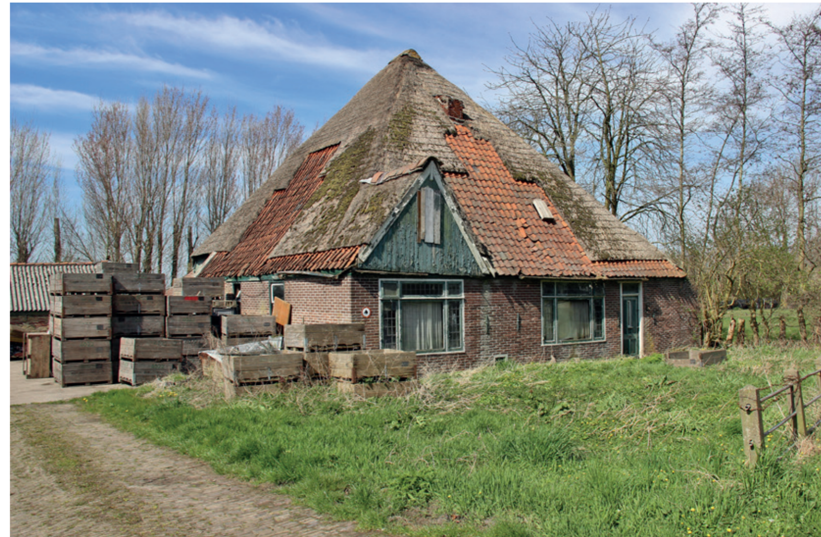
Een vervallen stolpboerderij in Hauwert
