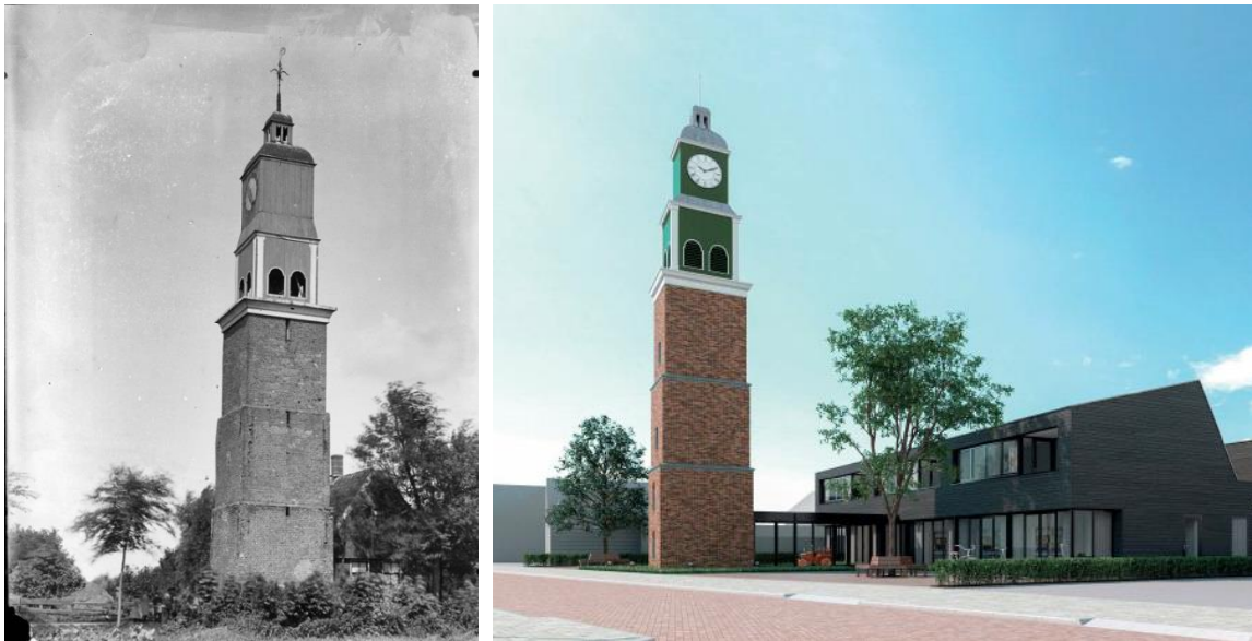
Afb. 10.4. De bescuittoren in Wormer. Foto links: NMF; foto rechts: Sprekend FKG Architecten aan de Zaan
