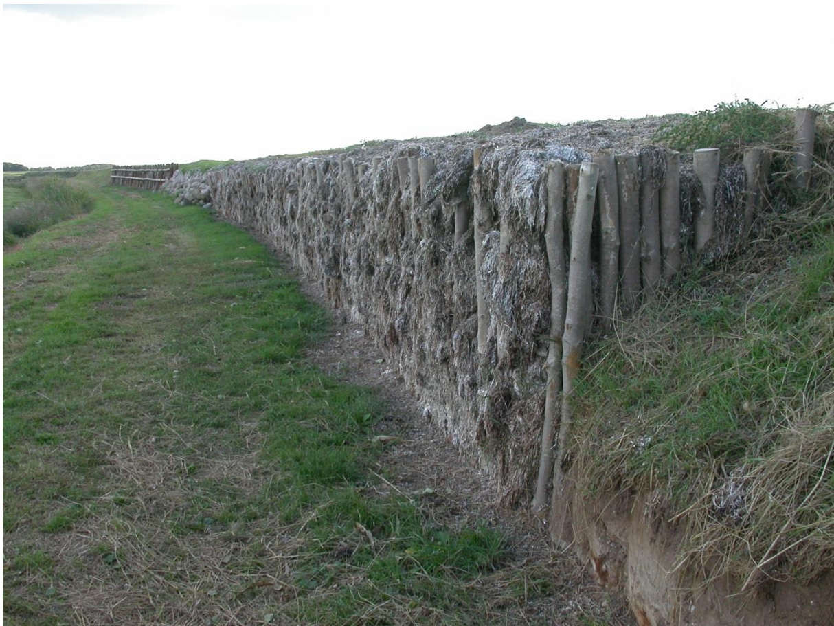
Afb. 5.5. Wierdijk. Foto: P. Saal.
