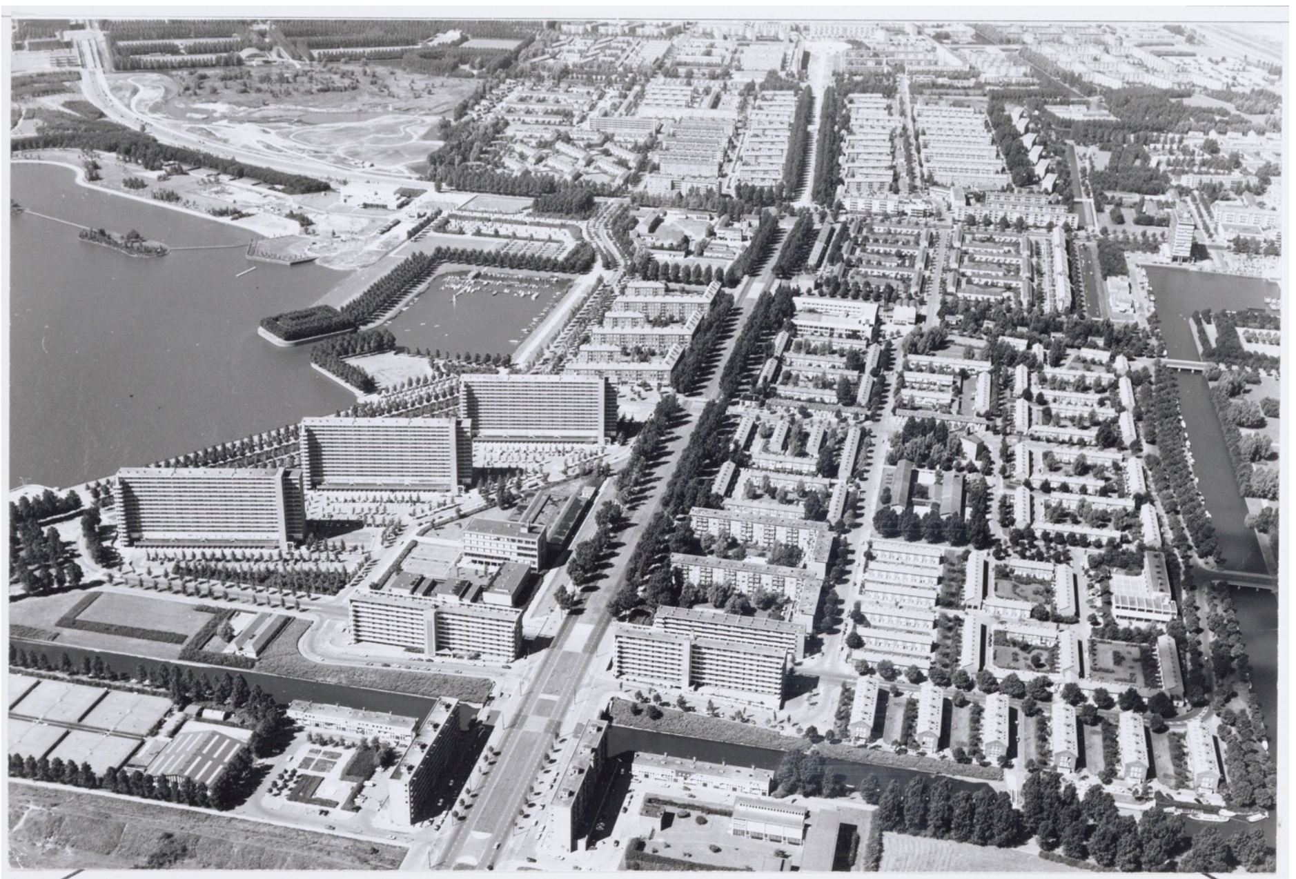
Hoogbouw en middelhoogbouw langs de hoofdwegen, laagbouw erachter
