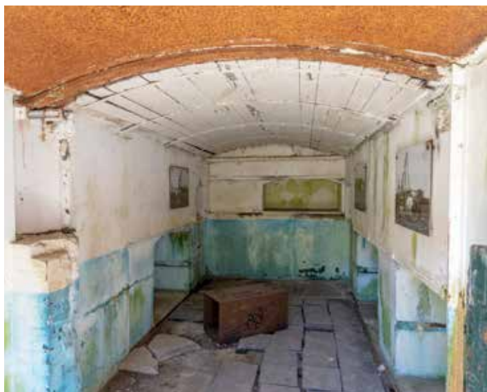
Interieur van een munitiebunker van Fort Diemerdam. Deze kustbatterij behoort bij de Stelling van Amsterdam (maar ligt buiten het provinciaal archeologiegebied)
