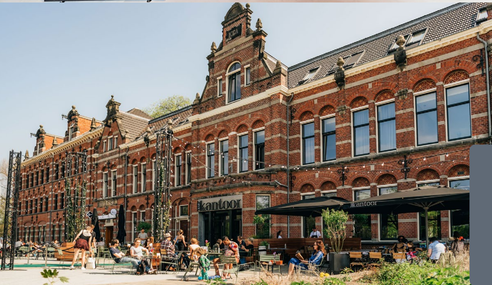
In een rijksmonument op het Westergasterrein in Amsterdam is het Conscious Hotel ondergebracht. Duurzame maatregelen, zoals de warmte-koudeopslag, isolatie en thermische compartimentering zijn met zorgvuldig pas-en meetwerk aangebracht of zijn reversibel. Het hotel stimuleert gasten om bewuste keuzes te maken, met onder meer de verkoop en het gebruik van duurzame producten. Foto: Arjen Velt (interieur) & Nooij Photography (exterieur)
