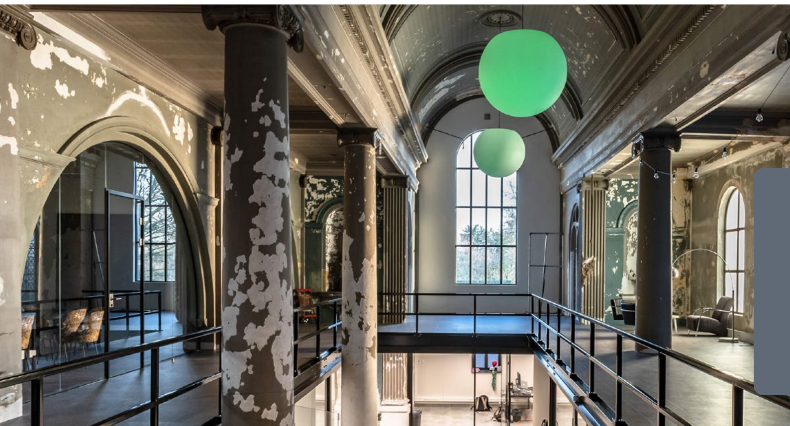
De Blokker in Blokker is op innovatieve wijze verduurzaamd en vervolgens in gebruik genomen als kantoor. Foto: Benno Ellerbroek
