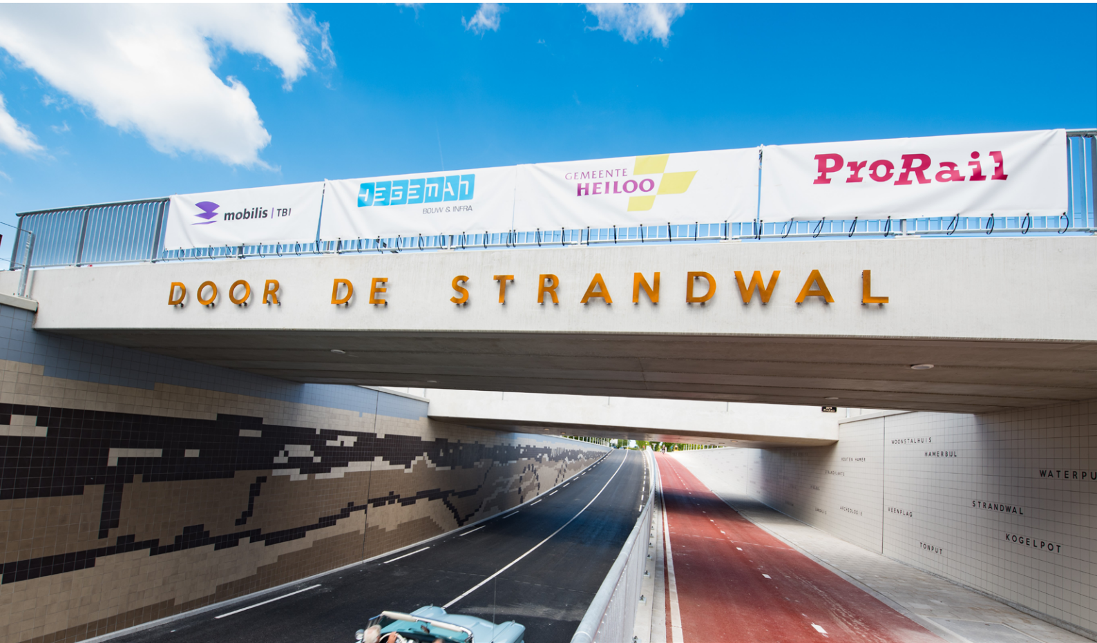
Afbeelding 8.1 Opening spooronderdoorgang Vennewatersweg (foto: Mobilis).
