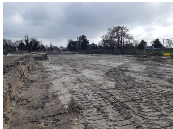
Afbeelding 8.7 Bouwplaats Vennewatersweg (foto: ProRail).
