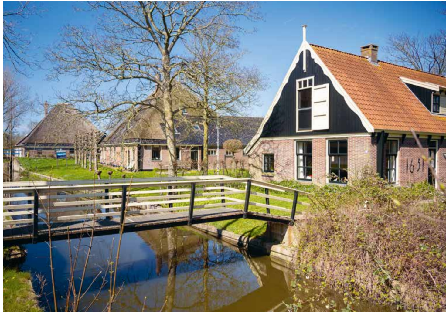
Stolpen in Barsingerhorn. Stolpenstructuren zijn waardevolle ensembles waarvoor een eigen werkingsgebied kan worden gedefinieerd om in te spelen op de samenhang en de specifieke kwaliteiten.
