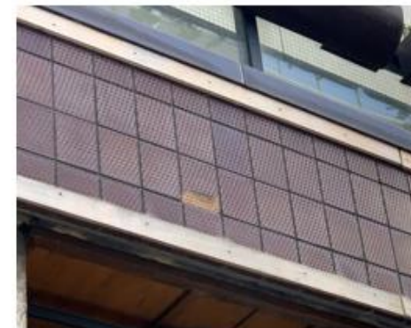
Netten op bestaand tegelwerk
