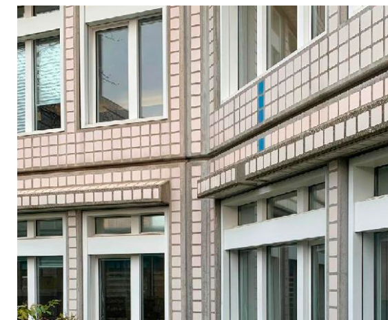
GEBOUW ALS VIERSEIZOENENJAS
