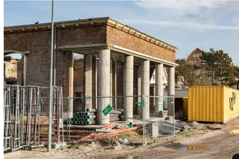
Logementsgebouw Den Helder, BOEi beeldbank
