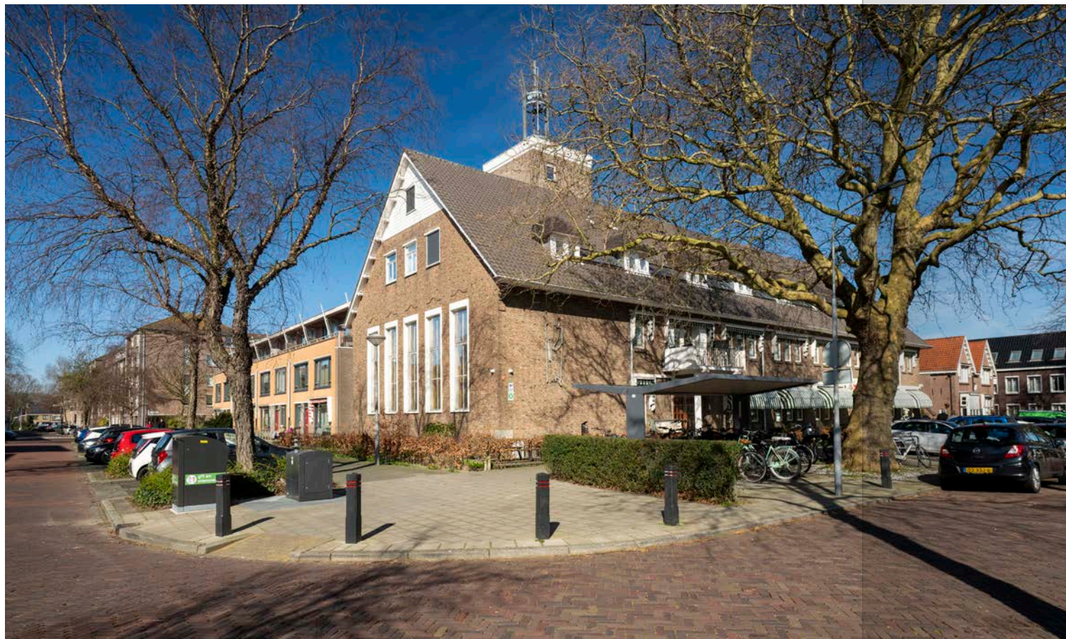
Het herbestemde Sint Josephhuis aan de Kerklaan in Heemskerk. Het gebouw werd in 1939 gebouwd naar het ontwerp van Nicolaas Molenaar jr. voor de zusters van de Allerheiligste Verlosser. Daarna werd het gebouw twee keer uitgebreid: in 1949 met een bouwdeel aan de noordoostzijde en in 1959 langs de Raadhuisstraat, dit deel is inmiddels gesloopt. | Foto Els Zweerink
